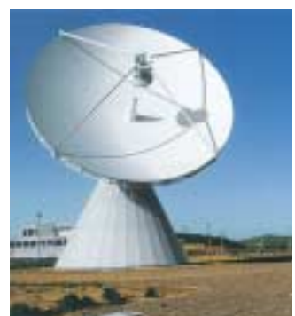
USV-Anlagen für die Rechner-systeme in Satellitenanlagen
