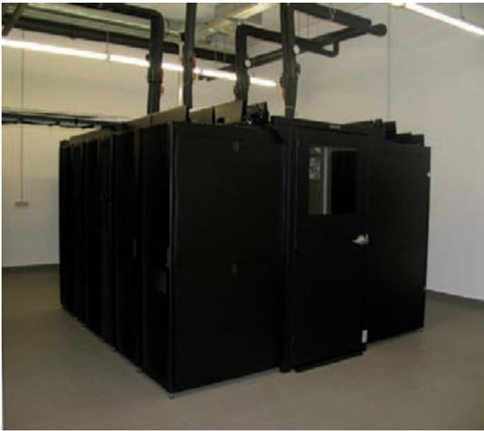
ventionellen Kaltgang-Einhausungen. Zudem bieten modular aufgebaute Warmgang-Lösungen wie die APC InfraStruxure den Vorteil der Skalierbarkeit. So lassen sich beispielsweise die Schrankreihen durch zusätzliche Schränke und Kühlungsmodule bedarfsgerecht erweitern.
